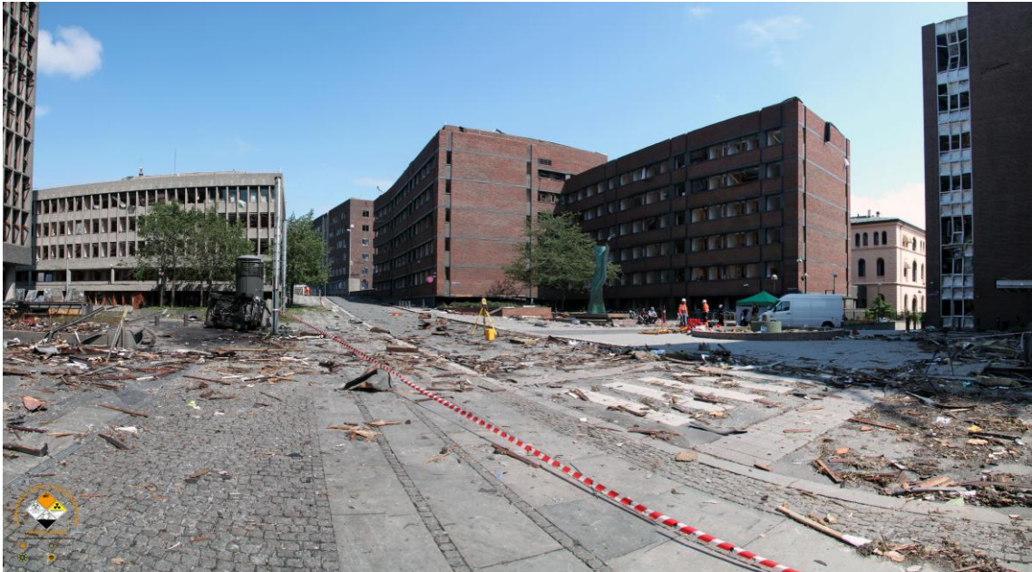
Grubbegatan sedd ifrån bombplatsen mot huvudbrandstationen.
