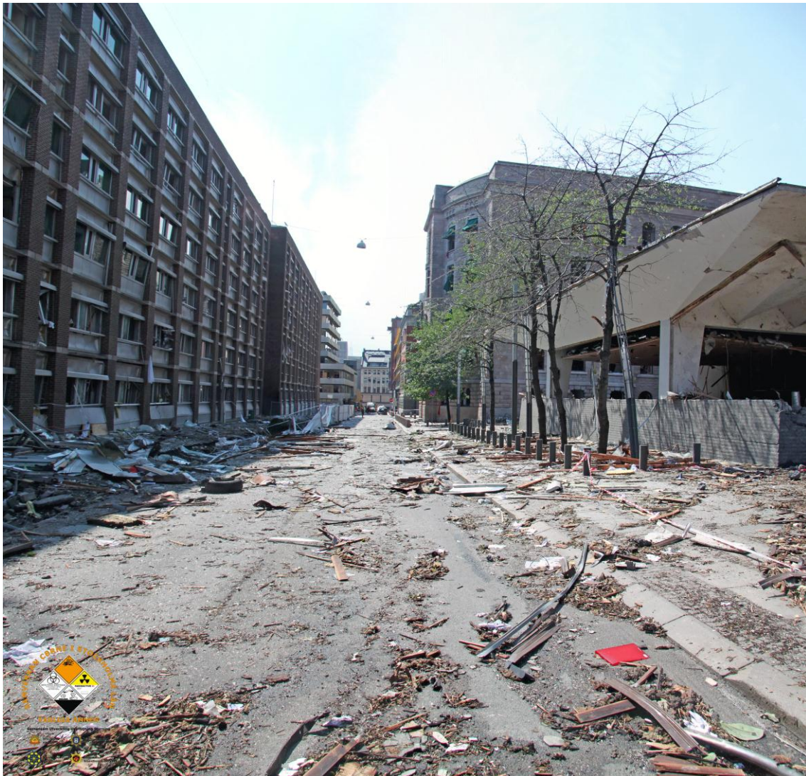
Grubbegatan sedd mot SV, bomplatsen till höger i bild och oljeministeriet till vänster och finansdepartementet snett till höger.
